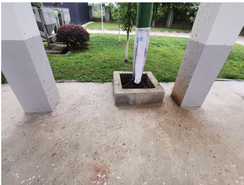
图 3.1-5 细格栅渠栅渣收集现状
