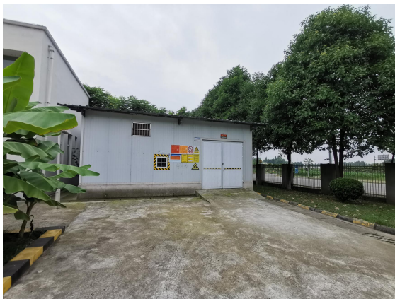
危险废物暂存间
