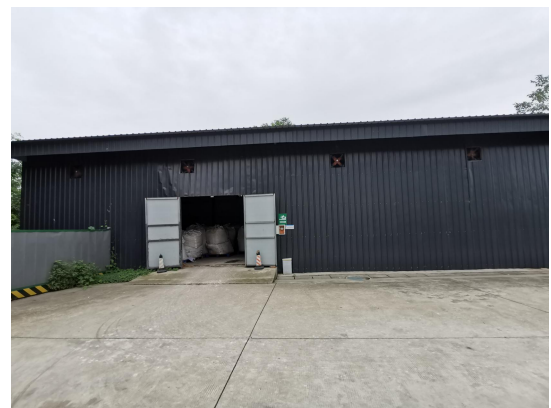
一般固废暂存间
